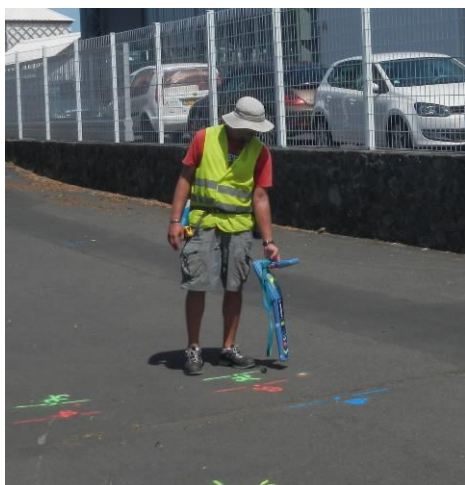
Figure 4 : détecteur électromagnétique en action à Saint Denis
