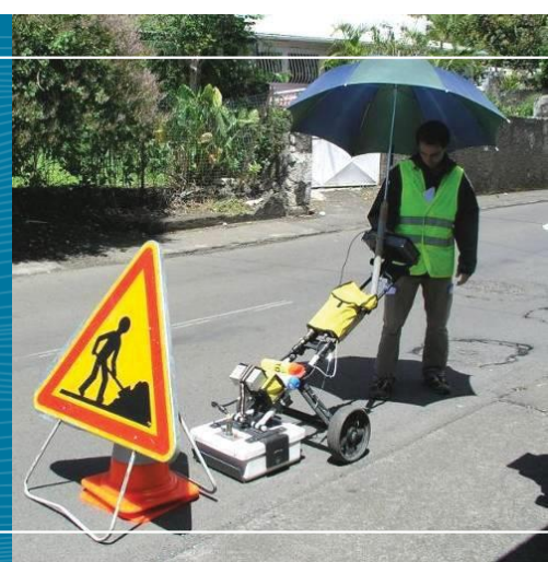
Figure 1 : Détection des réseaux à Saint-André
